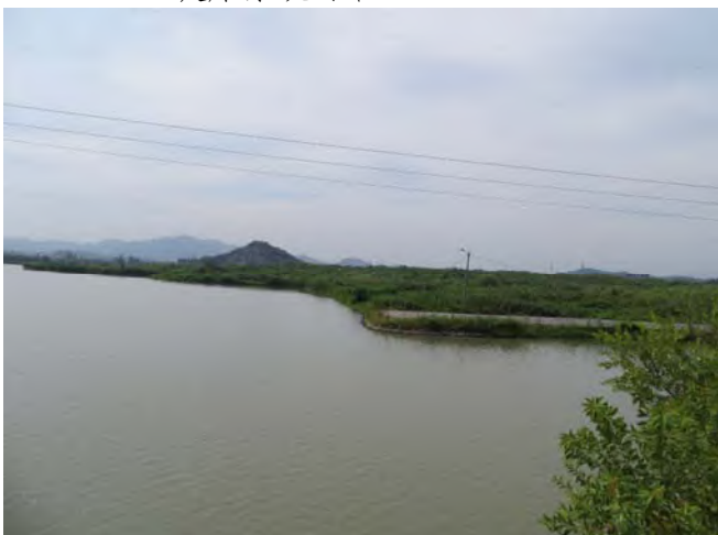
应急备用水源工程及扩建工程交界 (2013.8)
