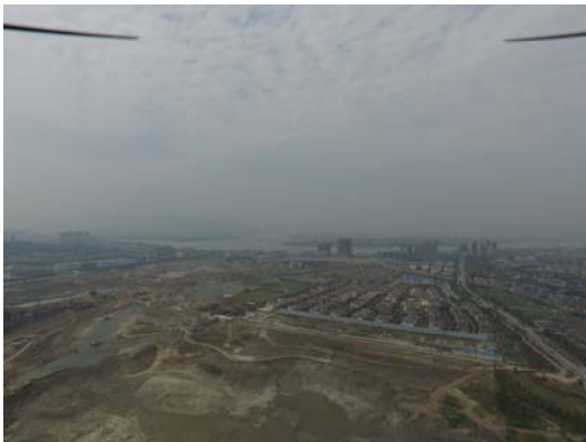
西侧堤线及施工区航拍 (2016.3)
