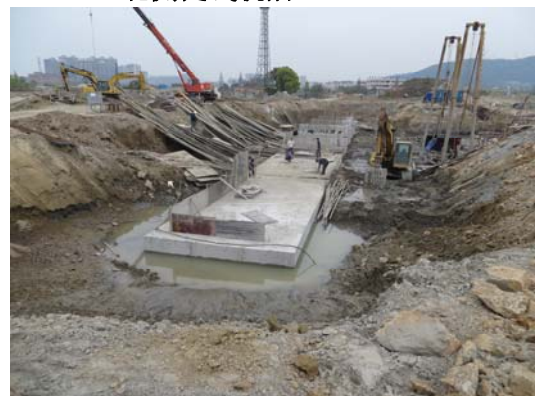
定山闸施工区 (2016.3)
