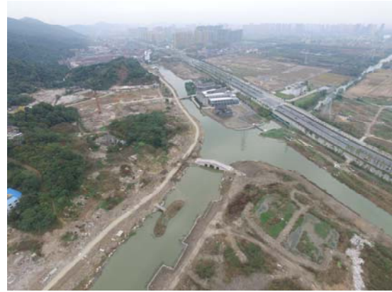
沿山闸、第二桥闸附近航拍 (2016.11)
