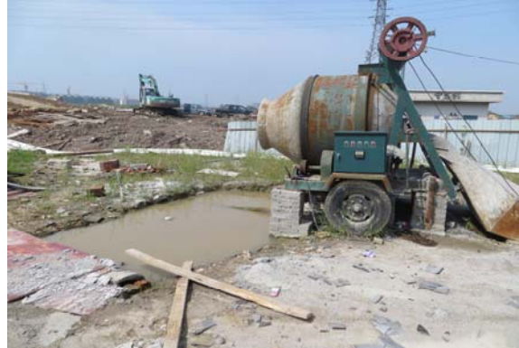
施工沉降池防护 (2016.6)
