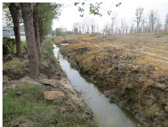
南线临时排水 (2016.9)
