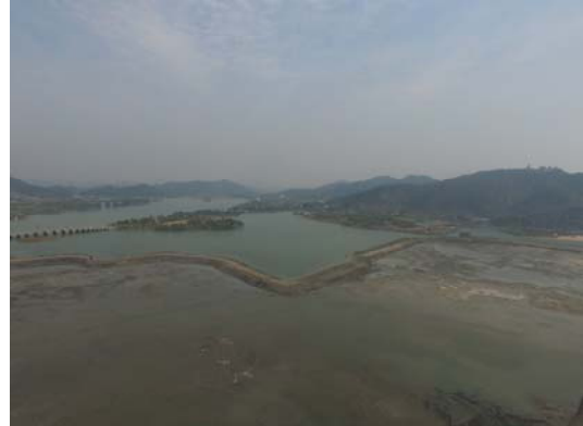
北侧堤线航拍 (2016.3)
