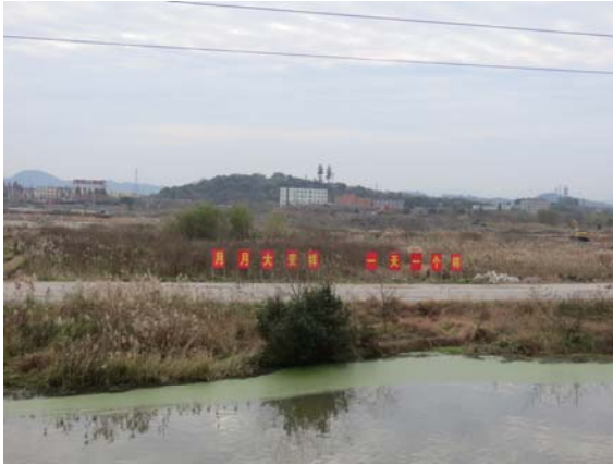
土方开挖施工 (2015.12)
