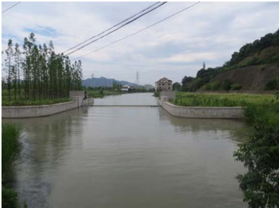
第二桥闸附近 (2017.6)
